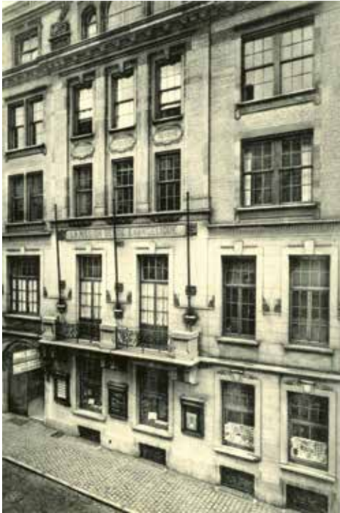
Gebouw BIB en BEZ, Staatsbladstraat 7 te Brussel. © ViaNova.
